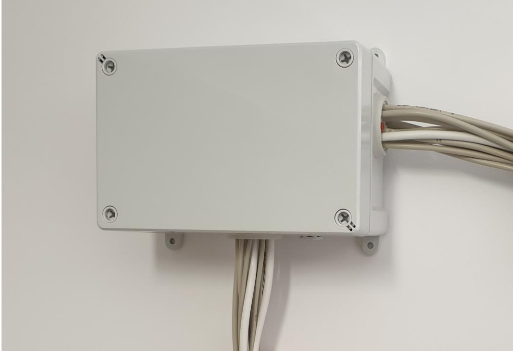
Fot. 2. Preferowana pozycja montażu urządzenia MDA1.
