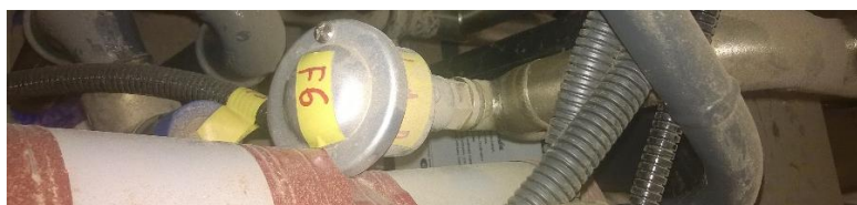
Zdjęcie nr_7 Nieakceptowalny sposób zabudowy czujnika temperatury.
