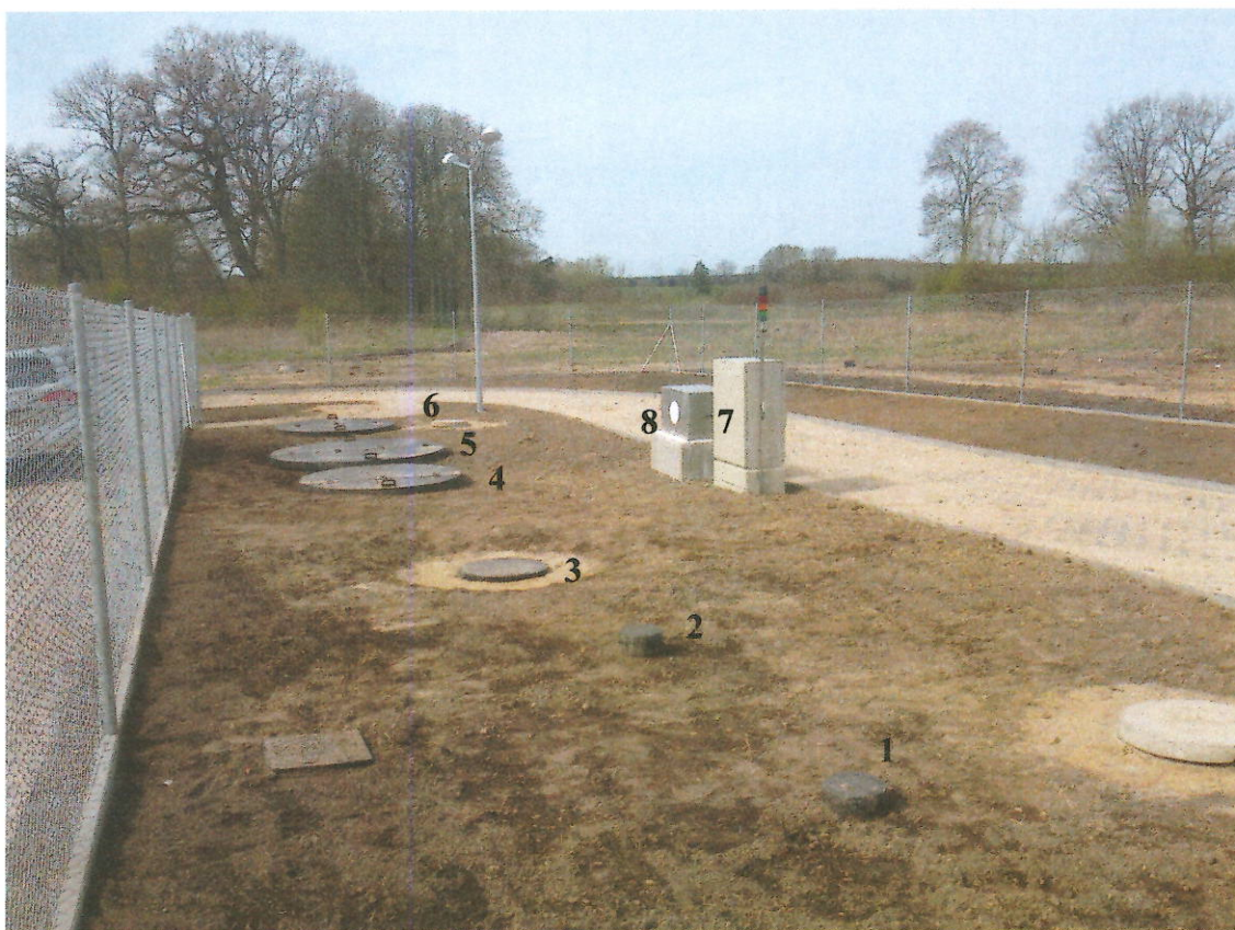
Fot 1. Widok oczyszczalni ścieków w Kczewie: 1 – kominek do kontroli osadu nadmiernego, 2 - kominek do kontroli osadu w osadniku, 3 - właz kontrolny w osadniku; 4 – reaktor nr 1; 5 – reaktor nr 2; 6 – osadnik wtórny; 7 – panel kontrolno-sterujący; 8 – dmuchawa.
