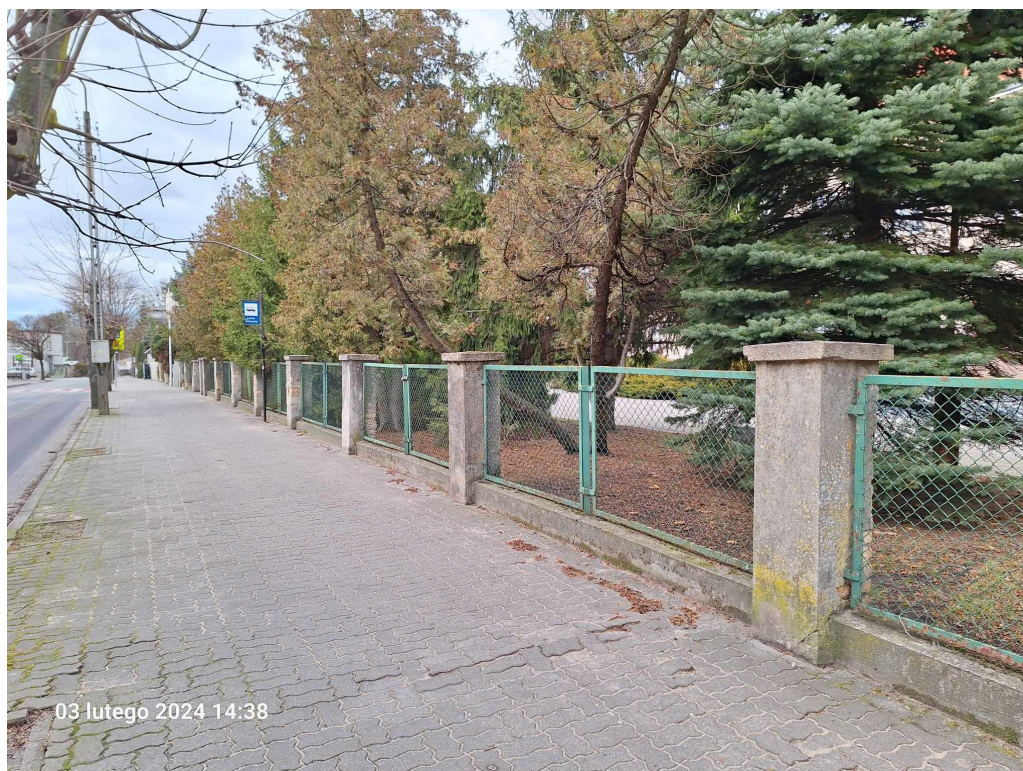
Fot. 3. Widok ogrodzenia przy przystanku autobusowym.
