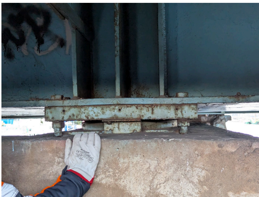
Rys.3.1. Łożyska stałe na filarze zachodnim (foto 30.12.2024)
