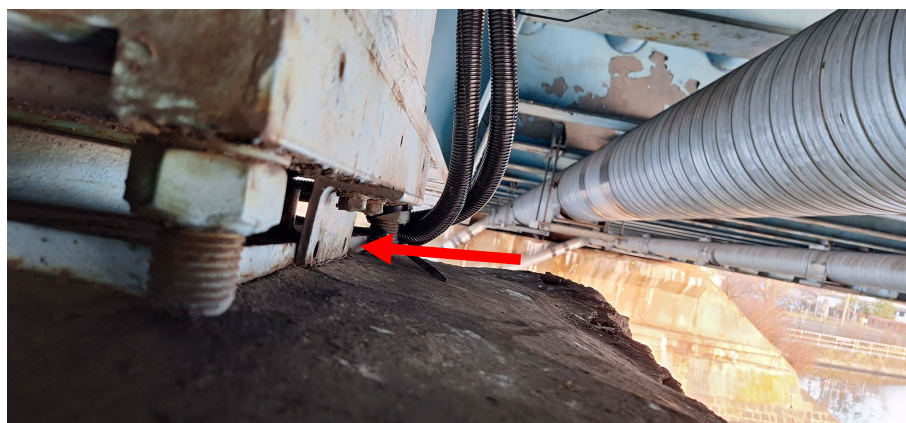
Rys.3.2. Łożysko stałe – widoczny brak śrub dolnych w łączniku (foto. 16.01.2025)
