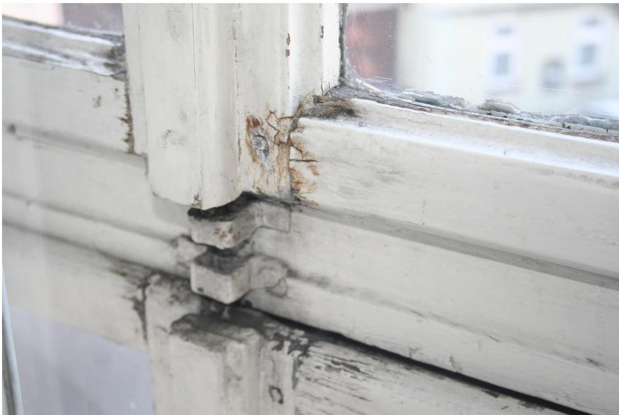
Stan zachowania – zniszczenia mechanizmu zamykania- okna nie są domknięte
