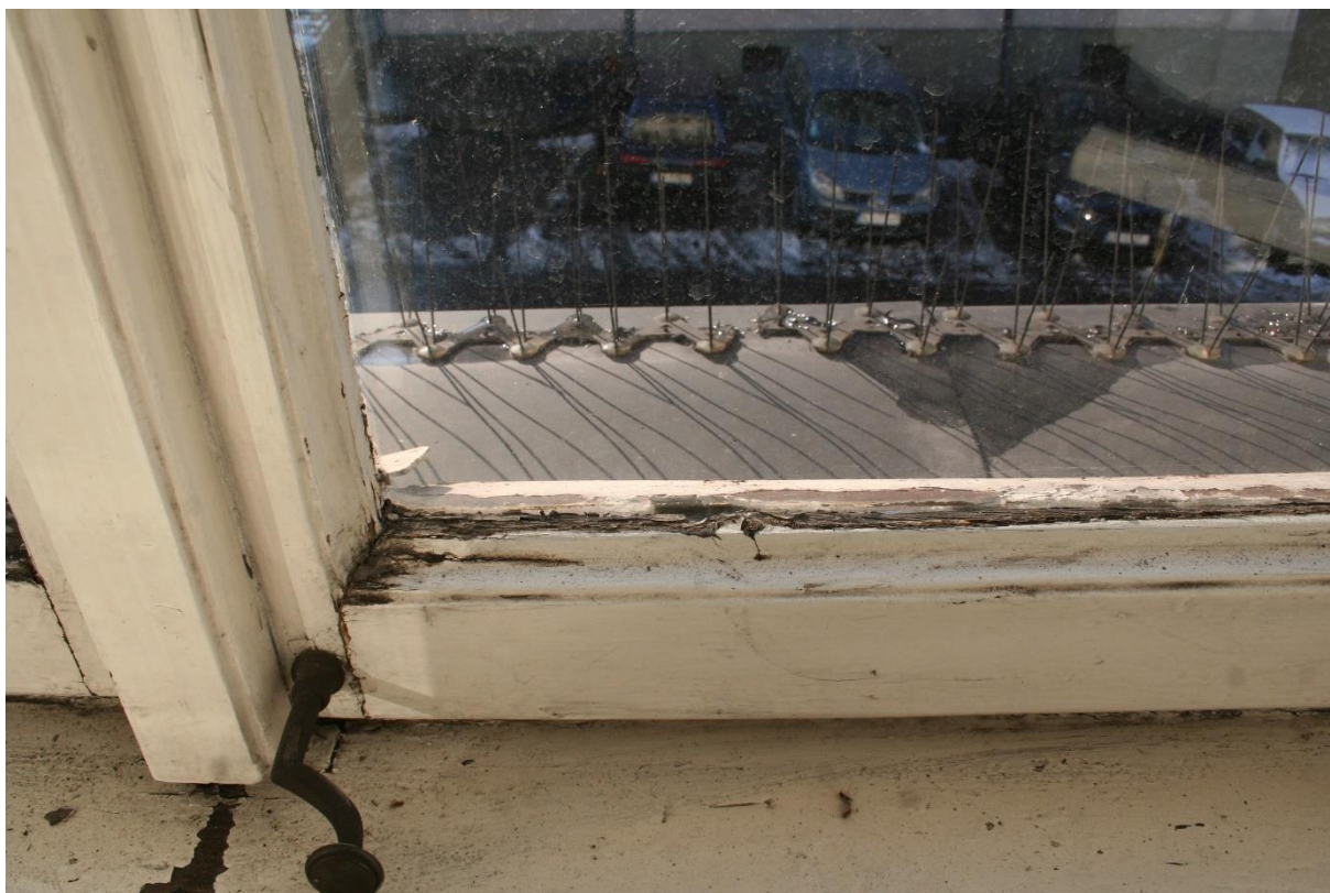
Stan zachowania- charakterystyczne zniszczenia w dolnej partii
