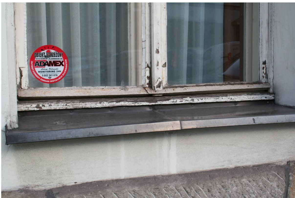
Stan zachowania – destrukcja drewna od strony zewnętrznej, opadnięcie skrzydeł
