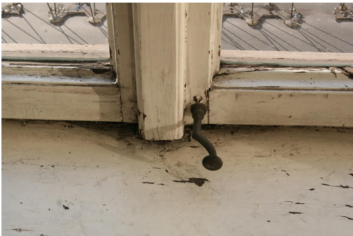
Stan zachowania- zniszczenia w dolnej partii szczególnie narażonej na działanie spływającej wody, skraplającej się wilgoci, brak blaszki blokującej pręt zasuw
