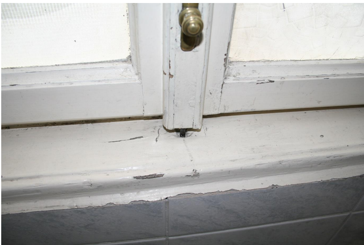
Stan zachowania – zniszczenia mechanizmu zamykania- okna nie są domknięte
