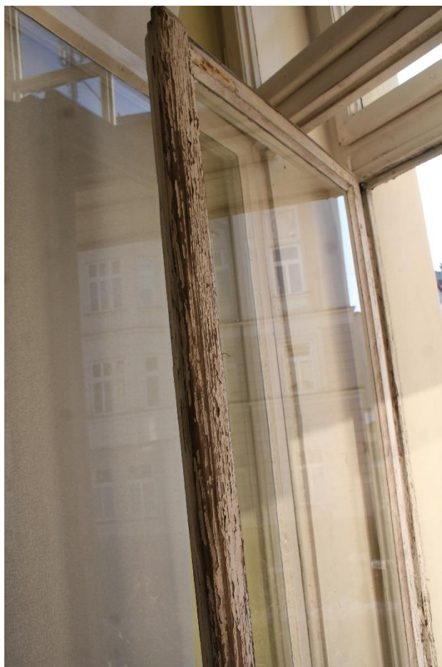
Stan zachowania elementów zewnętrznych narażonych na działanie zmiennych czynników atmosferycznych
