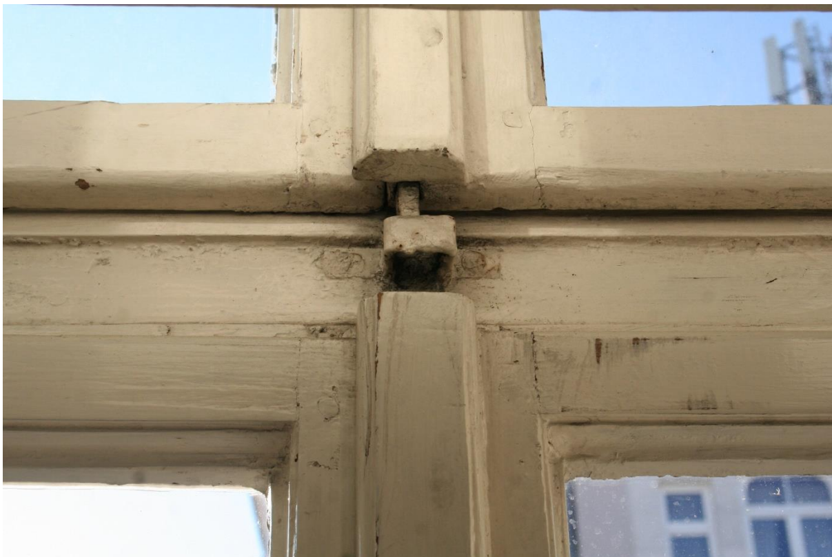
Stan zachowania- widoczne nieszczelności i odkształcenia skrzydeł, zepsuty mechanizm zasuw, górna część okna nie jest domykana
