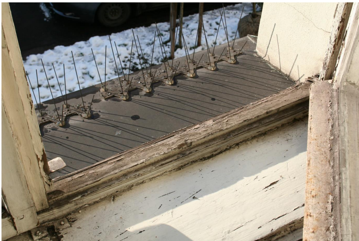
Stan zachowania – zniszczenia w partii dolnej, odkształcenie i uszkodzenie gniazd
