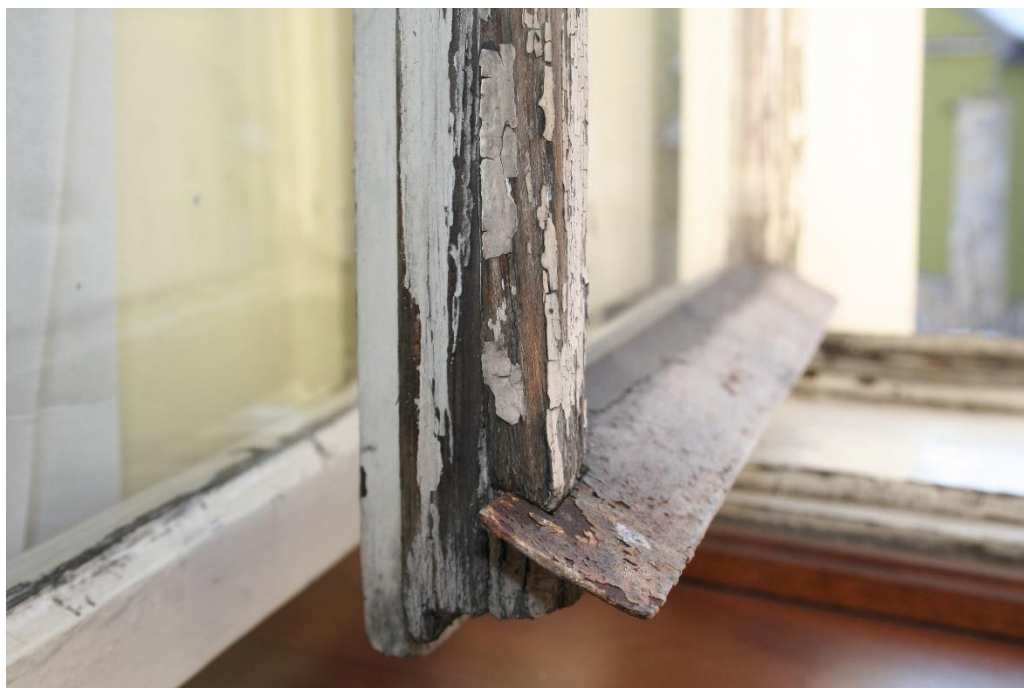
Stan zachowania elementów zewnętrznych narażonych na działanie zmiennych czynników atmosferycznych
