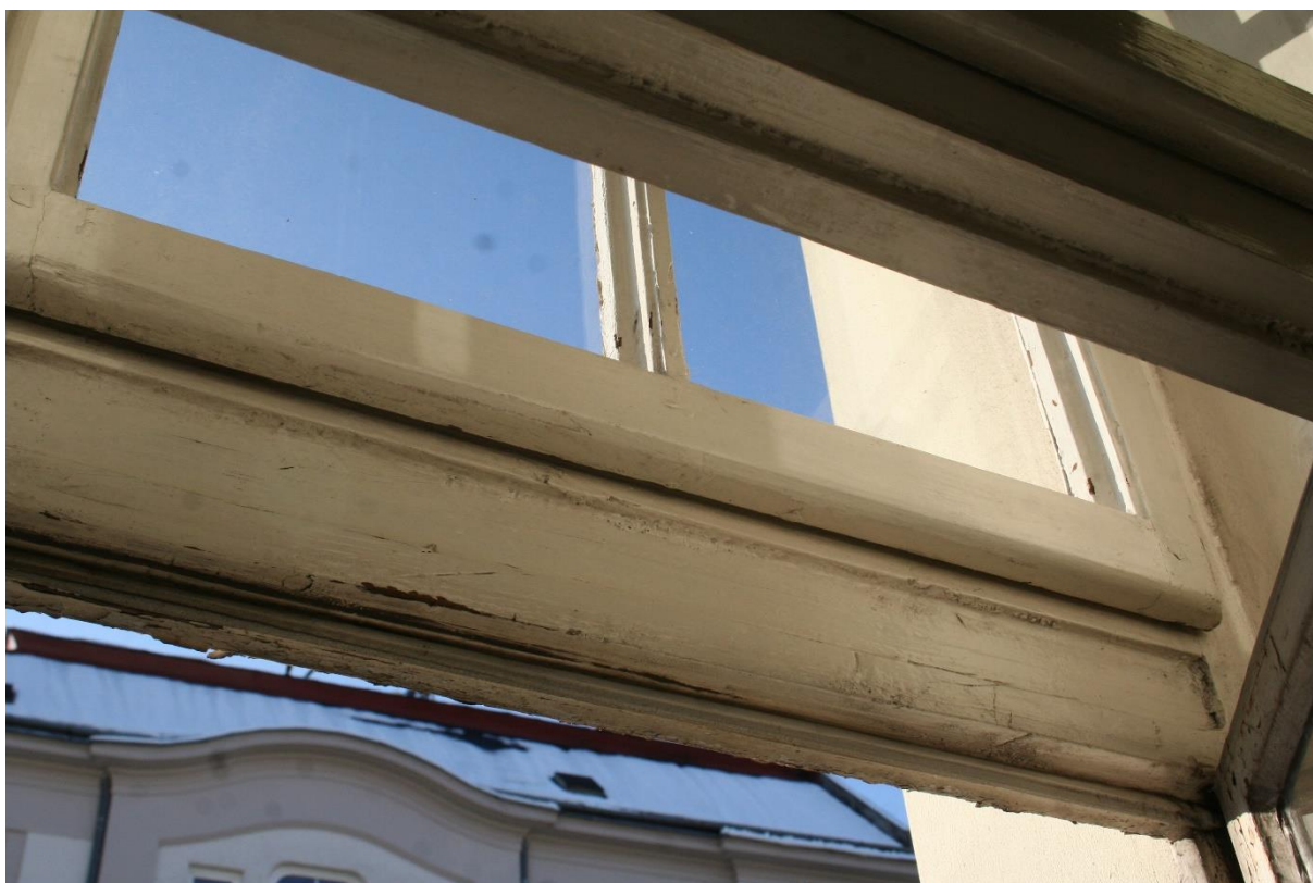
Okno nr 4 – widoczne nieszczelności górnych skrzydeł zewnętrznych
