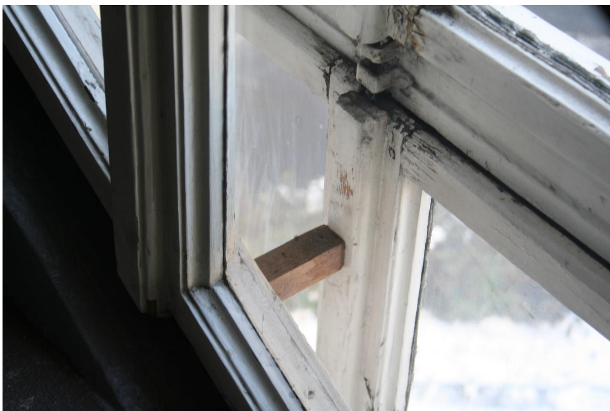
Okno nr 14a- widoczne odkształcenia, destrukcja drewna na całej powierzchni, sposoby na domknięcie odkształconych skrzydeł
