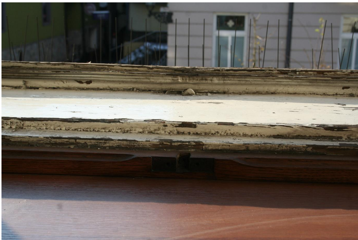
Stan zachowania- zniszczenia w dolnej partii szczególnie narażonej na działanie spływającej wody, skraplającej się wilgoci, brak blaszki blokującej pręt zasuw
