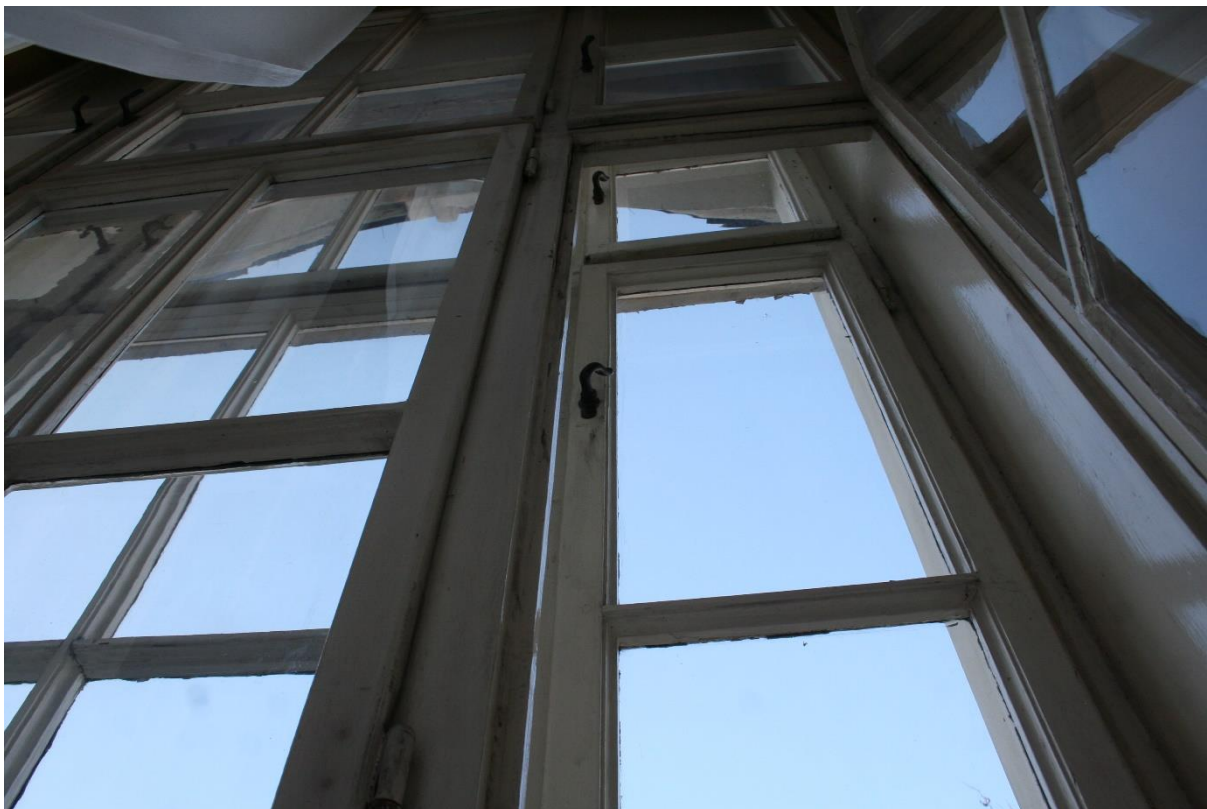
Okno nr 17 we foyer- widoczne nieszczelności i odkształcenia skrzydeł
