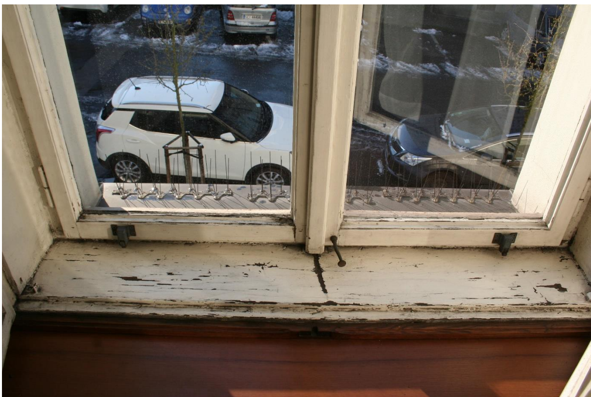
Stan zachowania- zniszczenia w dolnej partii
