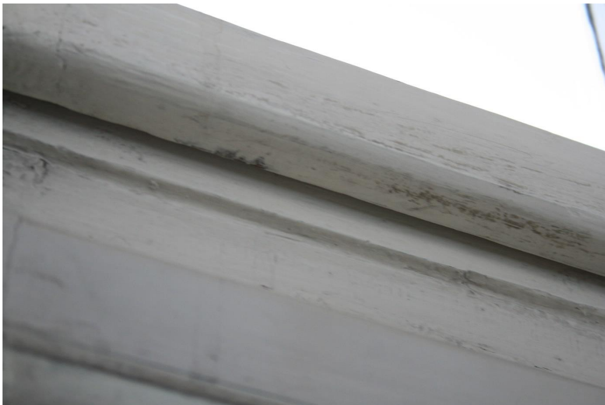
Okno nr 14a- widoczne odkształcenia, destrukcja drewna na całej powierzchni, sposoby na domknięcie odkształconych skrzydeł
