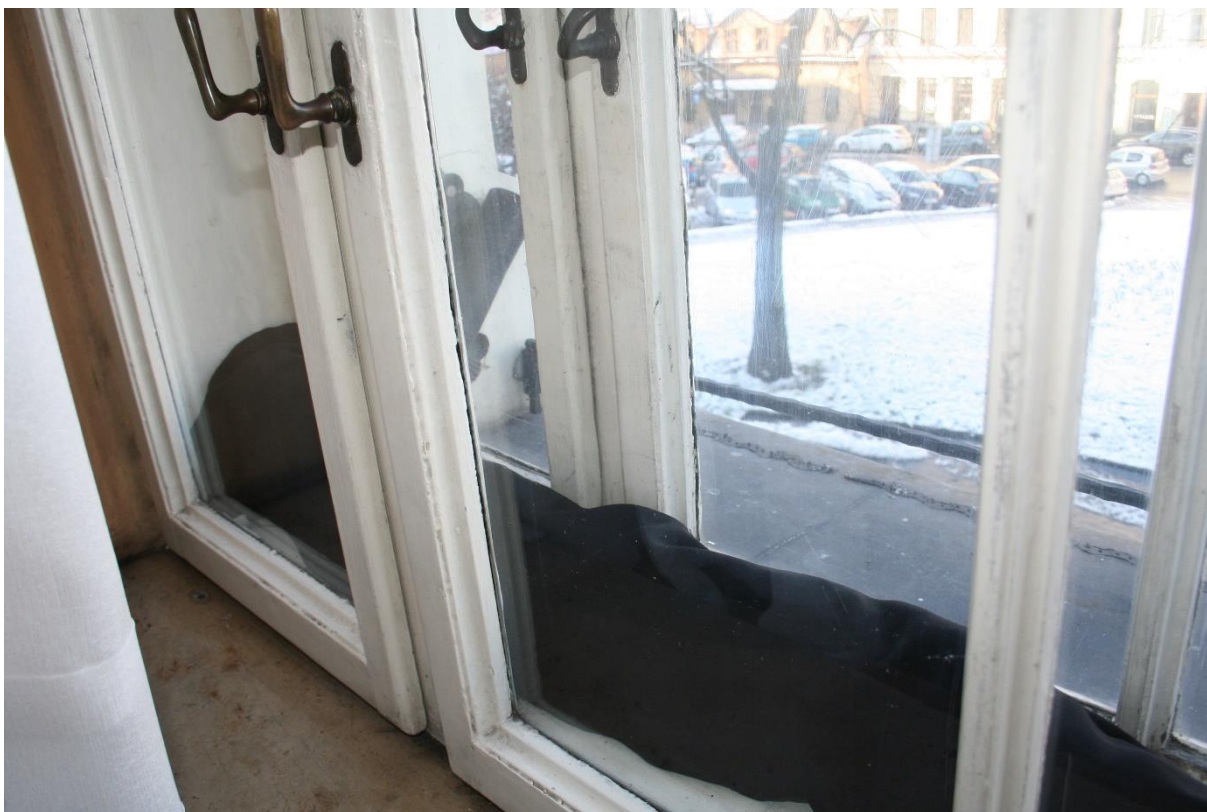
Okno nr 17 we foyer- widoczne nieszczelności i odkształcenia skrzydeł
