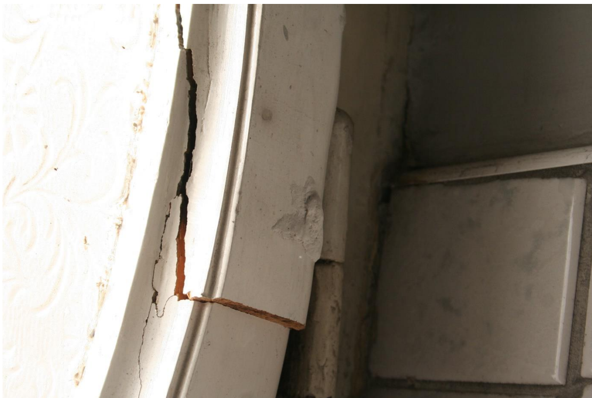
Stan zachowania – rozklejenie drewna skrzydła okiennego
