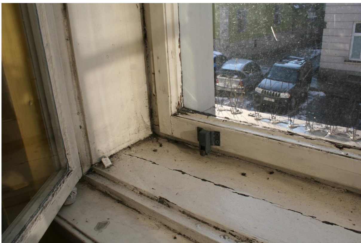
Stan zachowania- charakterystyczne zniszczenia w dolnej partii
