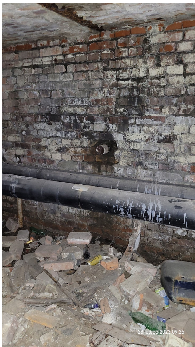
Ściana zewnętrzna. Odcięta rura wodociągowa.
