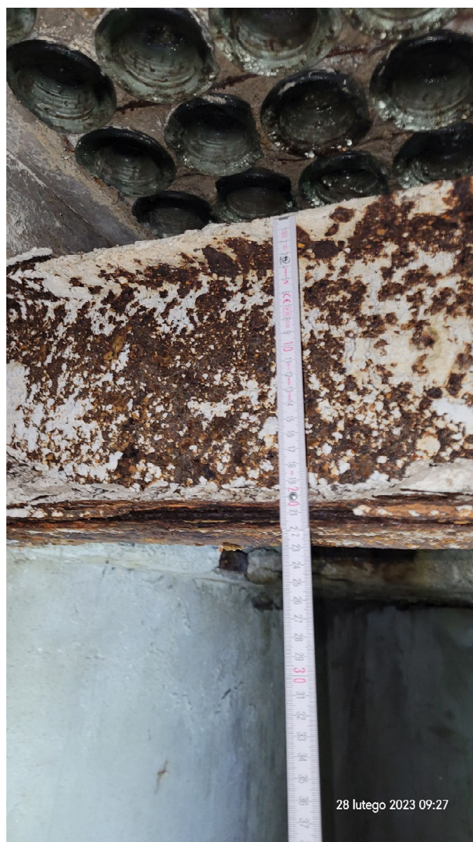
Belki stropowe całkowicie odsłonięte przy naświetlach.
