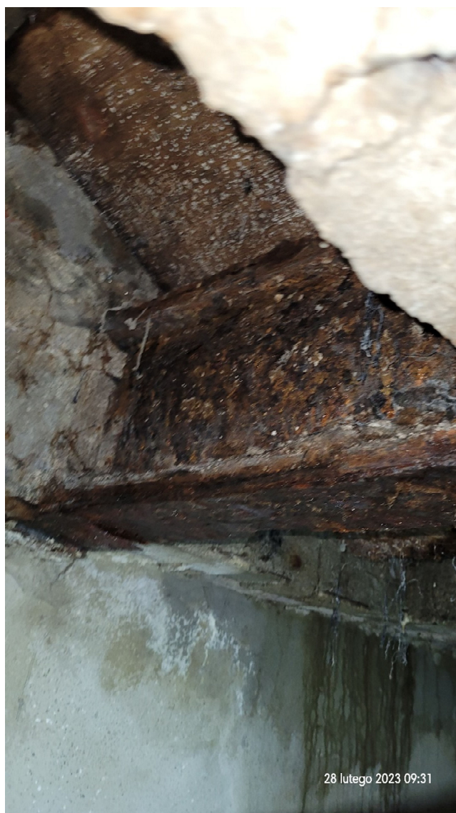
Belki stropowe całkowicie odsłonięte przy naświetlach.
