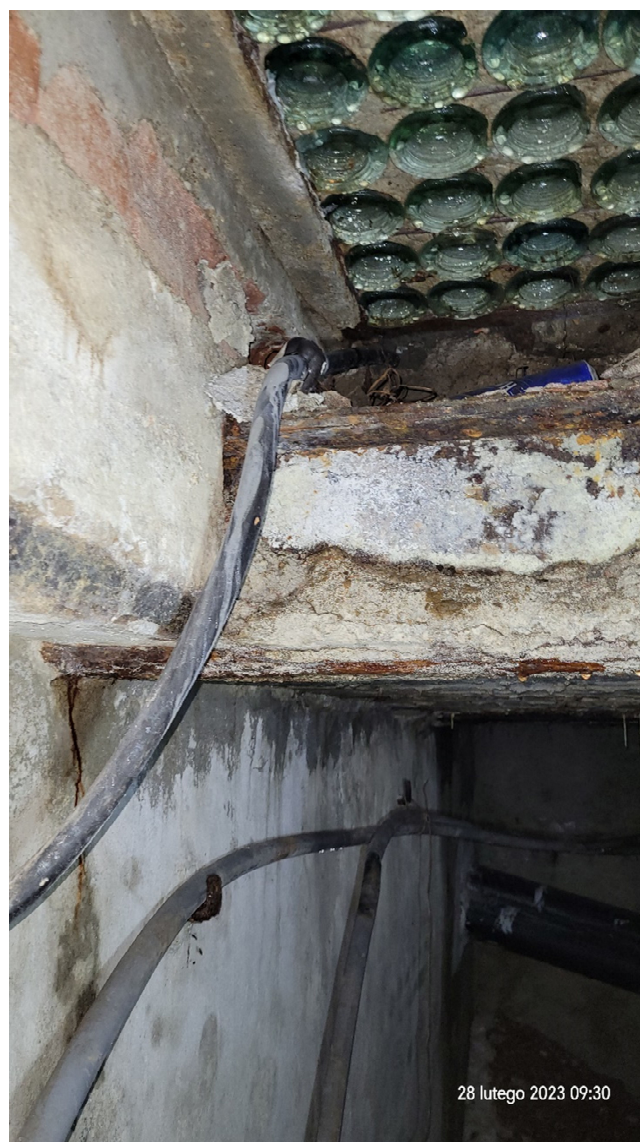
Belki stropowe całkowicie odsłonięte przy naświetlach.
