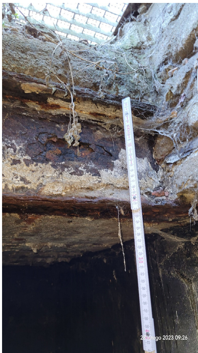
Belki stropowe całkowicie odsłonięte przy naświetlach.
