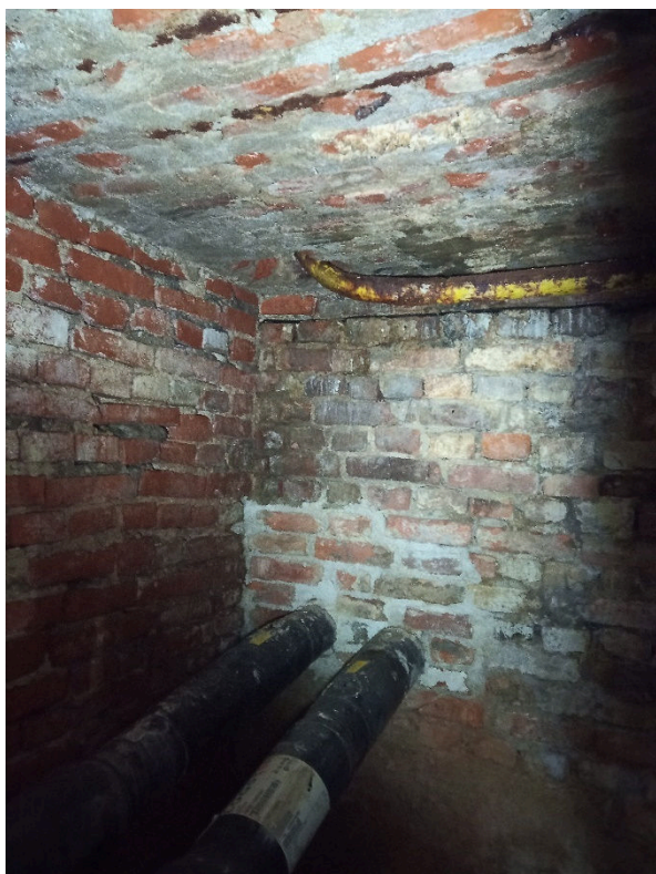
Wejście kolektora C.O. do budynku przy Kartuskiej 72.
