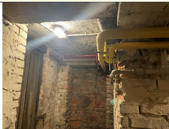
Zdjęcie nr 4 – widoczna instalacja centralnego ogrzewania wchodząca do pomieszczenia 00.14
