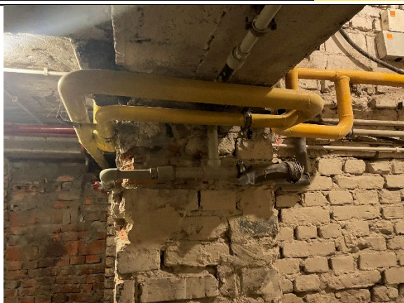
Zdjęcie nr 3- instalacja gazu, elektryczna i wody prowadzona po ścianie w przejściu pod podciągami w osi „b”
