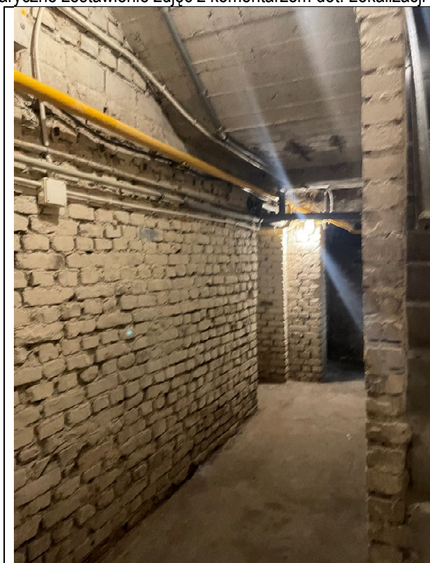
Zdjęcie nr 1 – pom nr 00.01 instalacja gazu, wody , elektryczna i teletechniczna prowadzona po ścianie. Wysoki poziom stropu.
