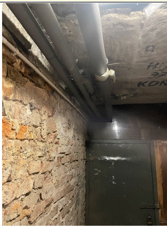
Zdjęcie nr 7 – instalacja wody, centralnego ogrzewania oraz przewód elektryczny zasilający oświetlenie ogólne w pomieszczeniu 00.08. Widok skierowany jest naprzeciwległą ścianą ze zdjęcia nr 7.
