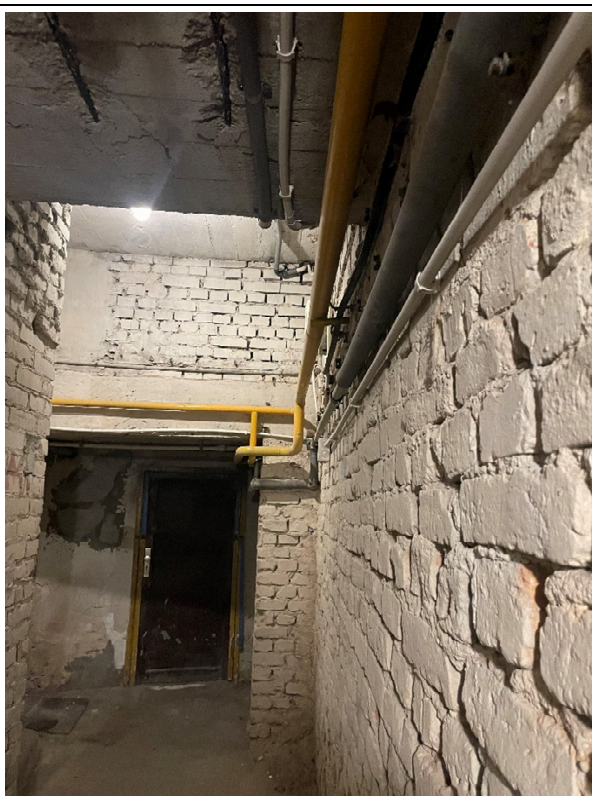
Zdjęcie nr 5 – instalacja gazu, elektryczna i wody na wzdłuż osi „3” w pomieszczeniu 00.01
